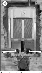
Cementare Hidrofix avendo cura di coprire con il cemento gli alloggiamenti in plastica dei vitoni di fissaggio WC.
